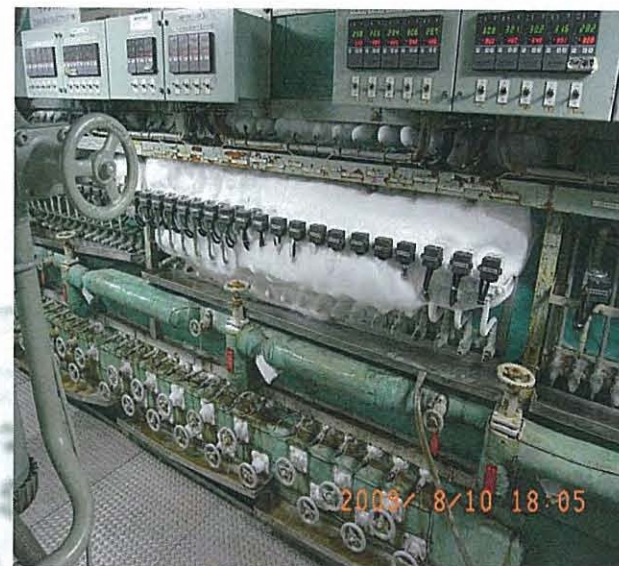
電子式膨張弁とコントローラー
