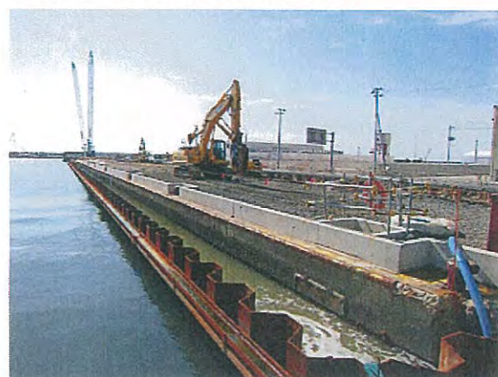
修復中の水揚げ岸壁の様子。
