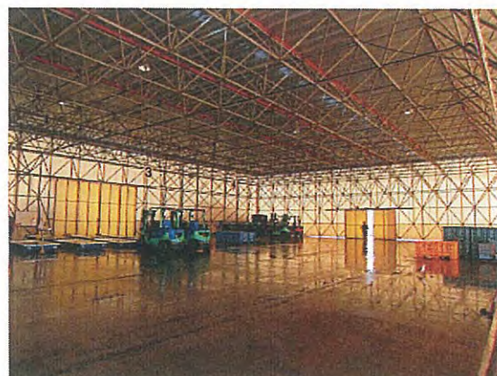
完成した仮設荷捌き所(内部)。
