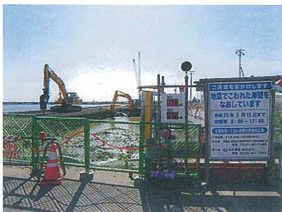
修復中の水揚げ岸壁の様子。
