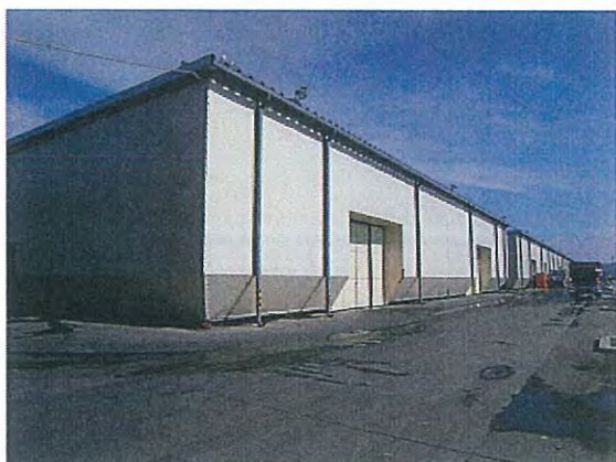
完成した仮設荷捌き所(外観)。
