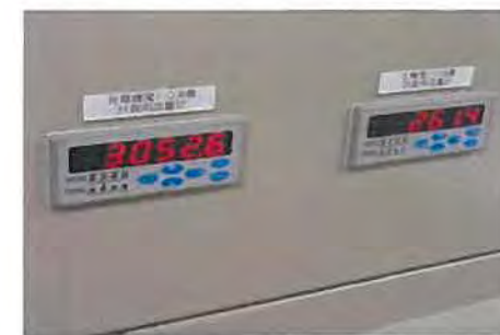
機関監視室 主・補機関燃料流量計表示部
