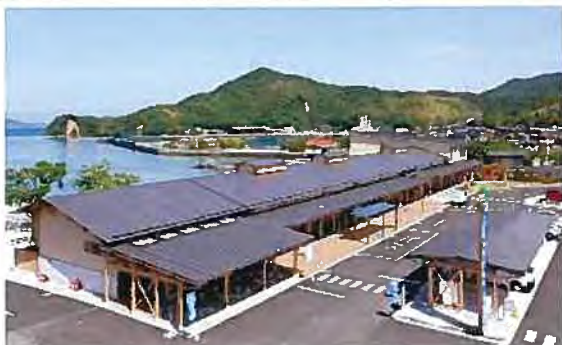
商業の拠点：道の駅「阿武町」全景 (H26. 4. 20リニューアルオープン)
