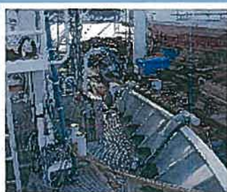
○船首甲板上にサイドローラーを設置
