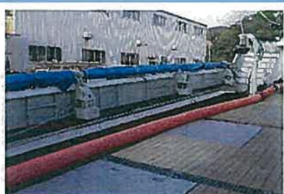
○上甲板上にミニボールローラー(網捌機)を設置
