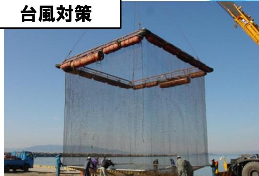
10m角型浮沈式鉄生簀
