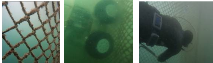
付着物が付いた鉄金網の洗網・潜水作業
