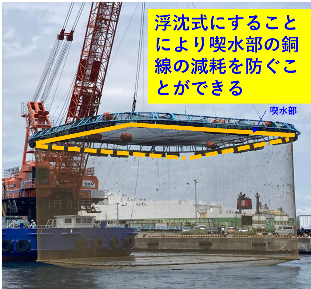
浮沈式大型銅金網生簀設置
