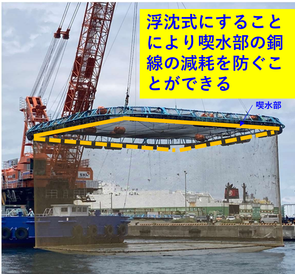
浮沈式大型銅金網生簀設置
