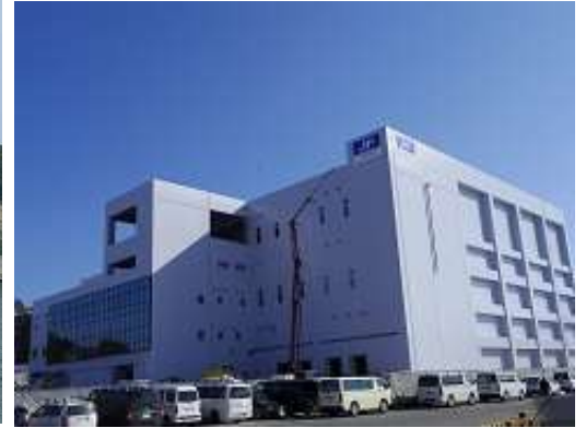
冷凍施設(平成27年3月)
