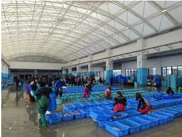
復旧した相馬原釜地方卸売市場
