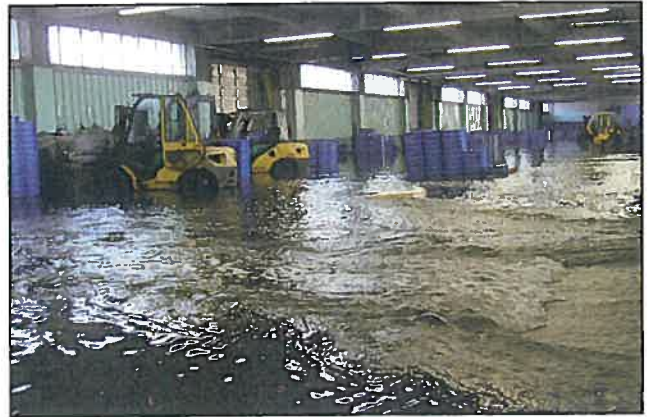
【市場内鮮魚冠水被害】
