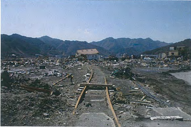
震災後の大槌町 J R 大槌駅付近
