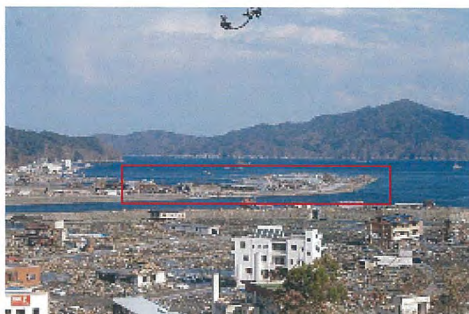
震災後の大槌町：大槌町湾 (同付近から撮影：川対面が水産加工団地)
