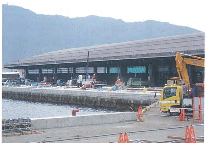
復旧中の宮古魚市場
