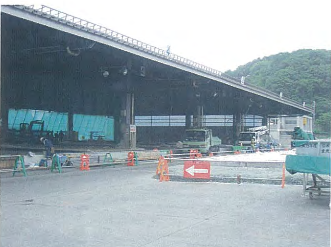
復旧中の宮古魚市場
