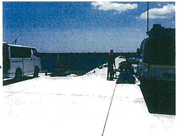
⑫第3市場東側岸壁
