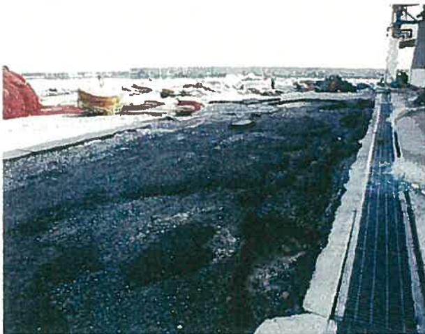
⑫第3市場東側岸壁
