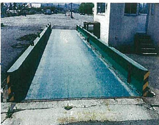
⑨第3計量施設(完了)
