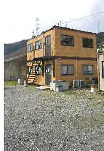
現在の本社事務所(女川町) プレハブ2階建て建物の2階部分
