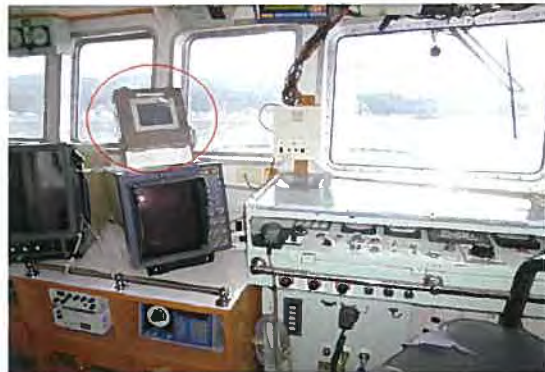
操舵室に設置された燃料消費モニター
