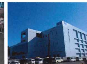
冷凍冷蔵施設
