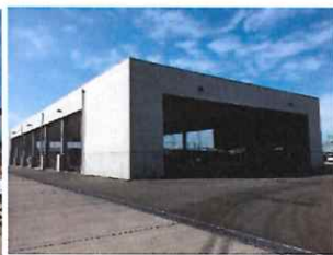
冷凍荷捌き施設
