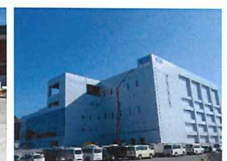
冷凍冷蔵施設
