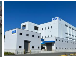
冷凍冷蔵施設
