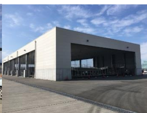
冷凍荷捌き施設
