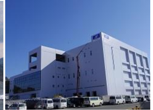
冷凍施設(平成27年3月)
