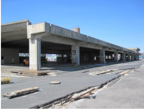
荷捌施設(小名浜、沼之内)
